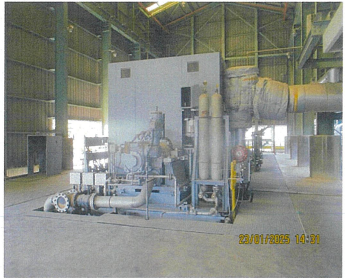
มาตรการควบคุมเสียงดังที่แหล่งกำเนิด (Cover guard)
